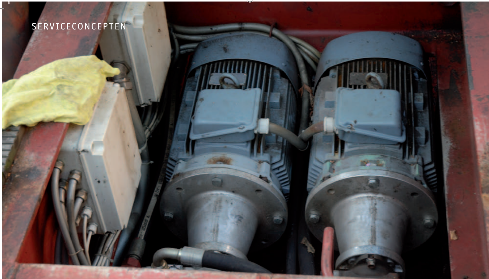
De attractie wordt aangedreven door twee elektromotoren van elk 37 kW
