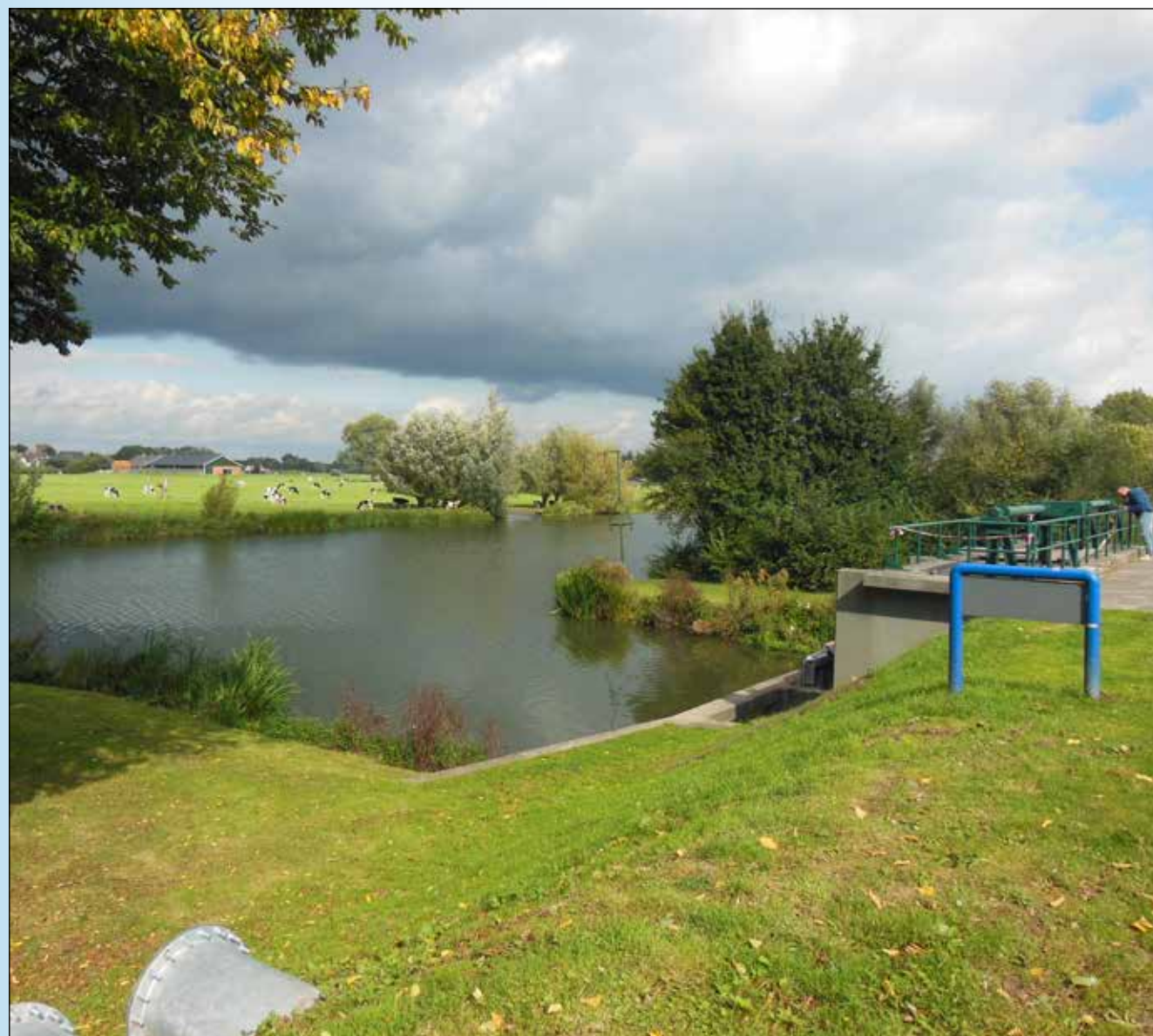
Uitstroomzijde van het gemaal.
