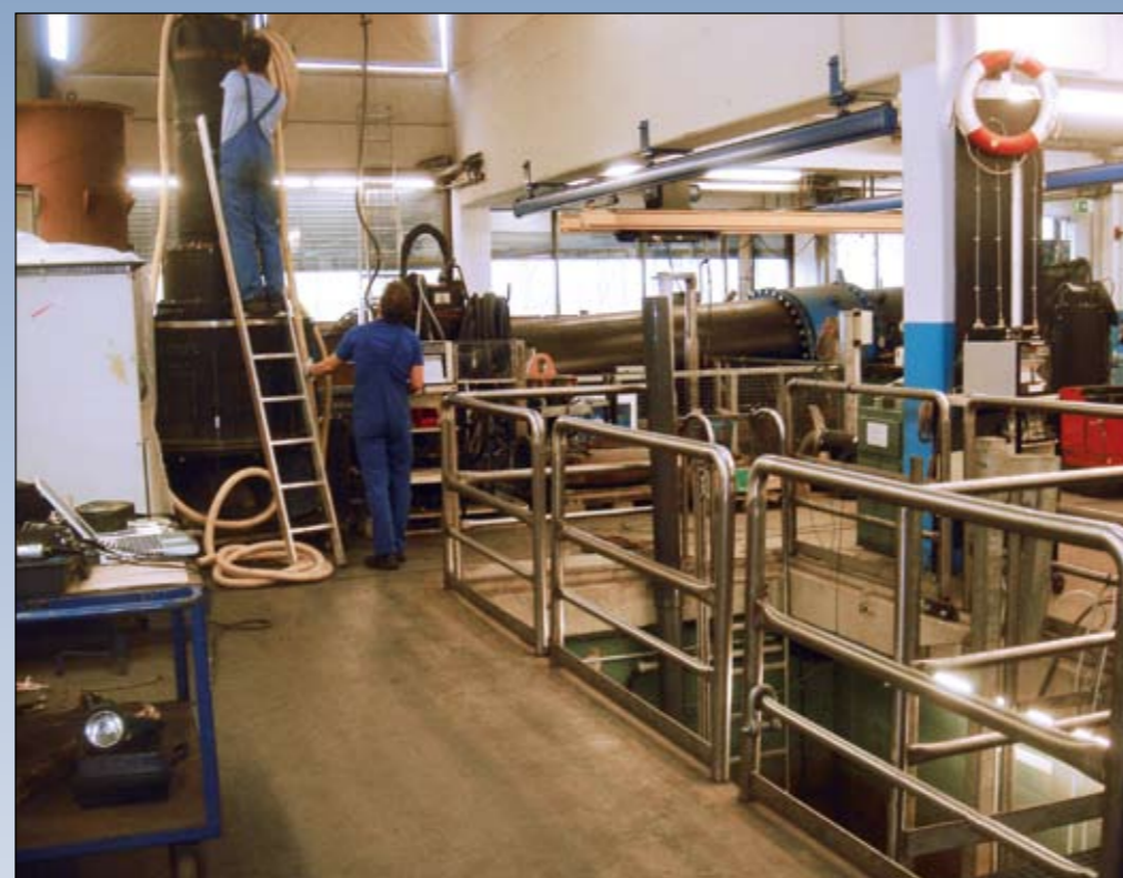
Eén van de dompelpompen wordt opgehangen op de testlocatie.
